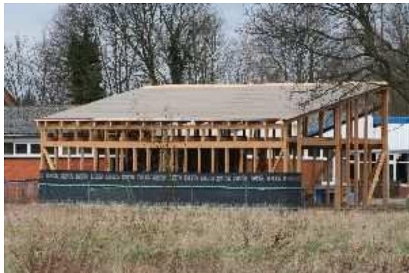
13.04.06 Durch das stürmische Wetter wurde ein großer Teil der Dachpappe abgerissen. Sie mußte neu befestigt und zusätzlich durch Latten gesichert werden.
