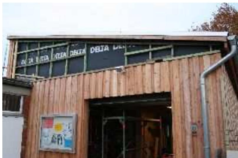
30.12.06: Zum Jahresende ist die vordere Verkleidung fertig bis auf einen kleinen Ausschnitt, in den eine Luke für das obere Bootlager eingesetzt werden soll.
