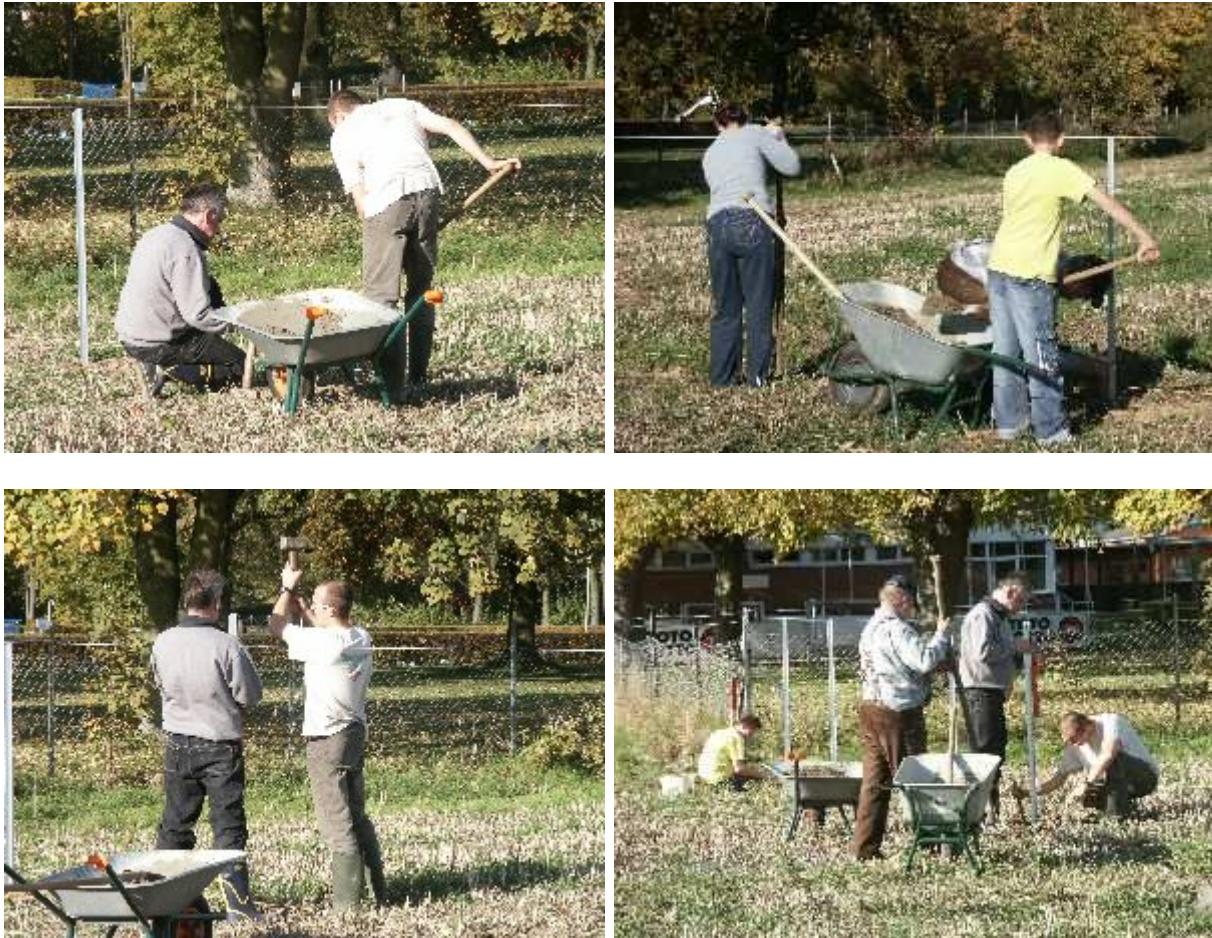
**Die hintere Reihe ist fast fertig, der letzte Pfosten wird gesetzt.**
